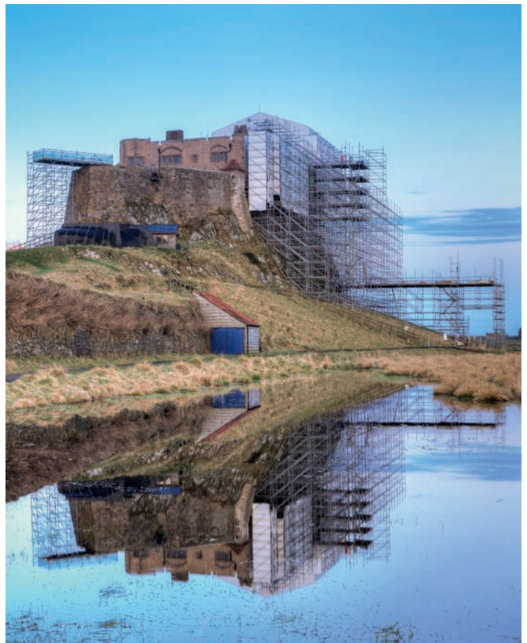
Beispiel eines Stützgerüsts für eine freistehende Fassade
